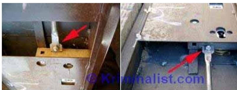
**Фото 24.** Вид крепления нижней и верхней тяг, винты облитые клеем.
