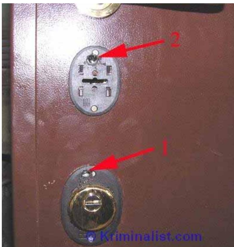
**Фото 34.** Результат сверления. Отметка 1-отверстие в обход цилиндрического механизма, для снятия блокировки и сдвига пластины, закрывающей скважину для ключа сувальдного механизма. Отметка 2-отверстие в проекции стойки ригеля.
