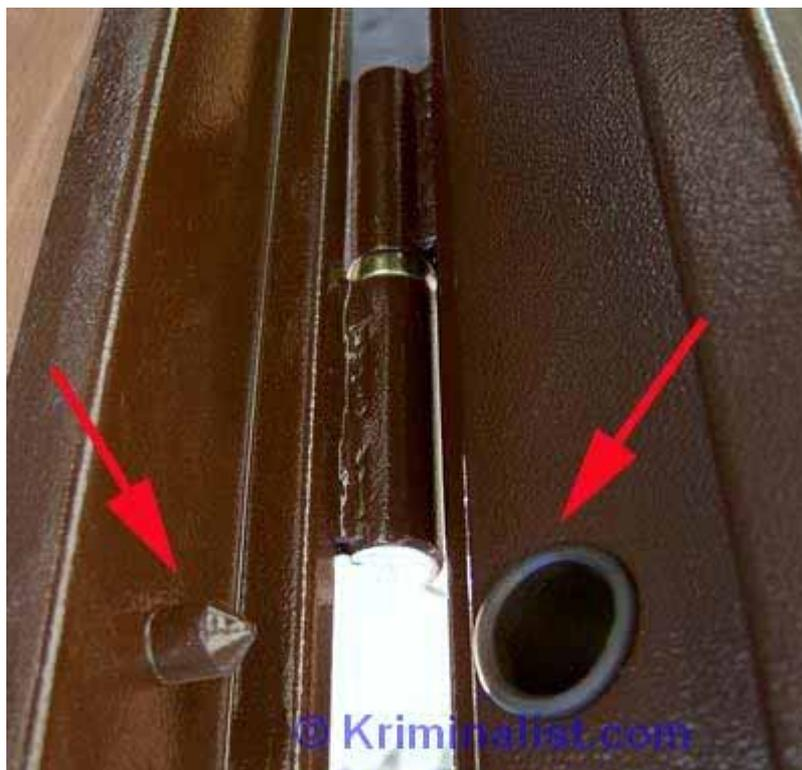
**Фото 6.** Вид противосъемного штыря (слева) и отверстия в коробке для него.
