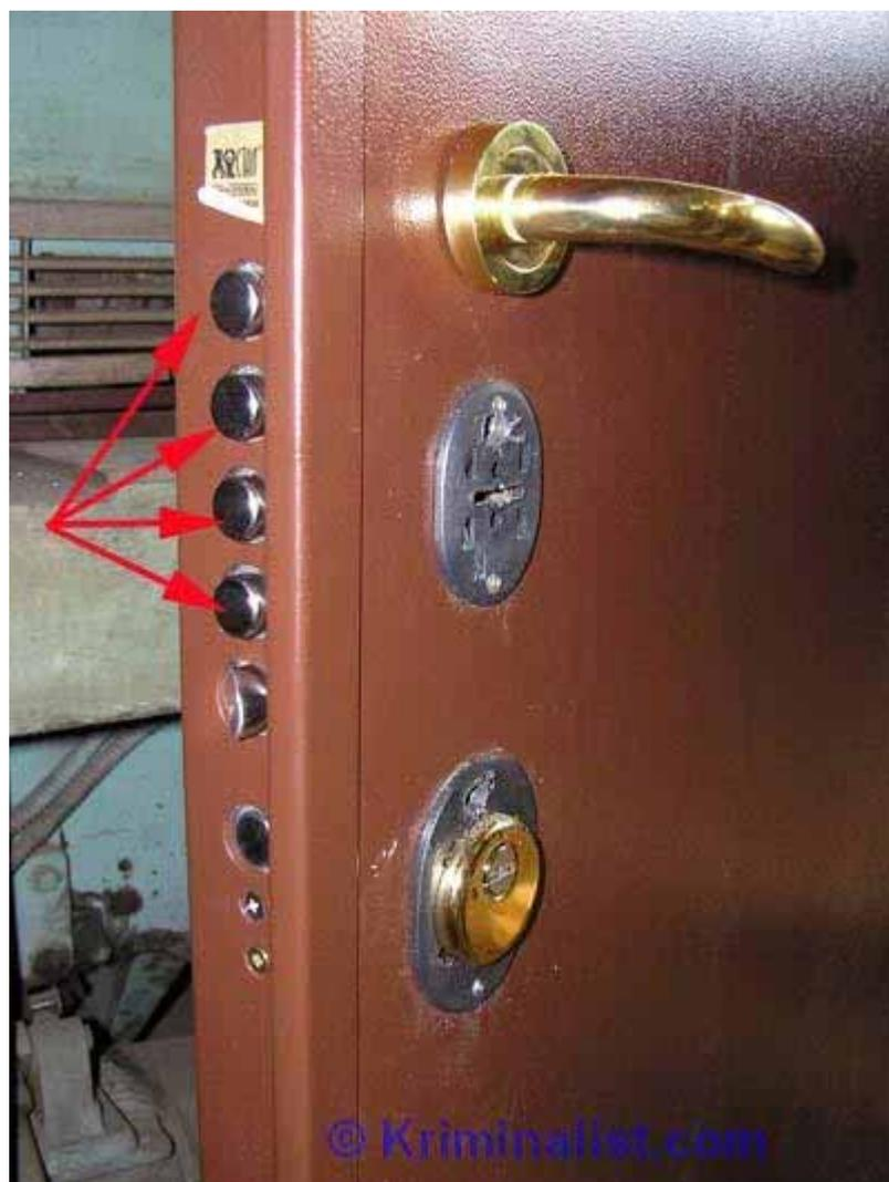
**Фото 41.** Красными стрелками показаны ригели, выдвинутые из двери при запираении замка на один полуоборот ключа. В таком положении они не заходят в дверную коробку, т.е. дверь не закрывается.
