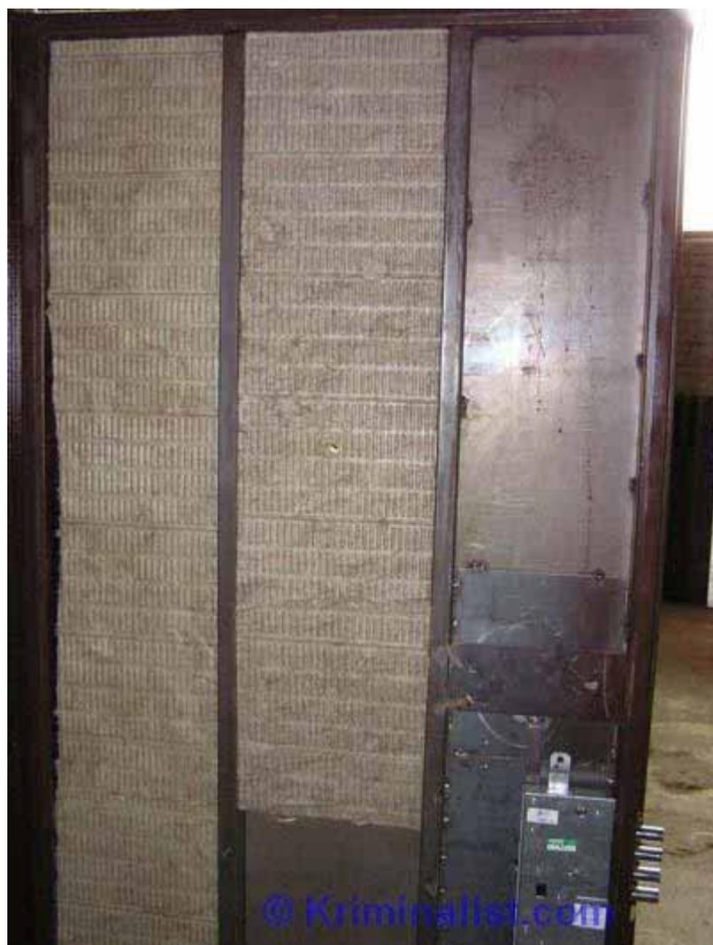
**Фото 21.** Вид фрагмента двери. В правой части видны точки крепления усиливающего профиля.
