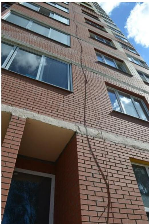
8.3. Отваливаются русты меж плиточных перекрытий по всему периметру дома. Русты не армированы. Частично отсутствуют кирпичи в фасаде дома.
