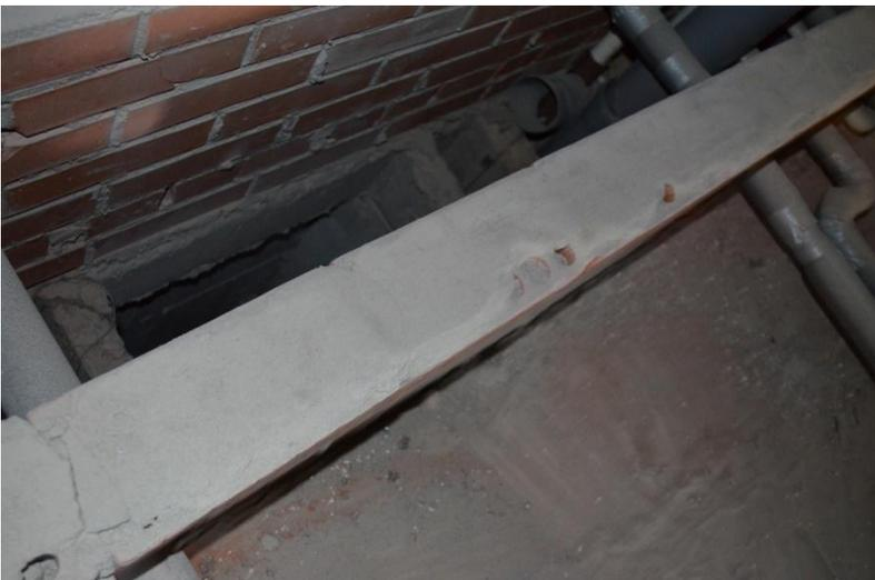
7.7 Отсутствуют откосы оконных блоков у входа на технические этажи и у всех окон технических этажей.
