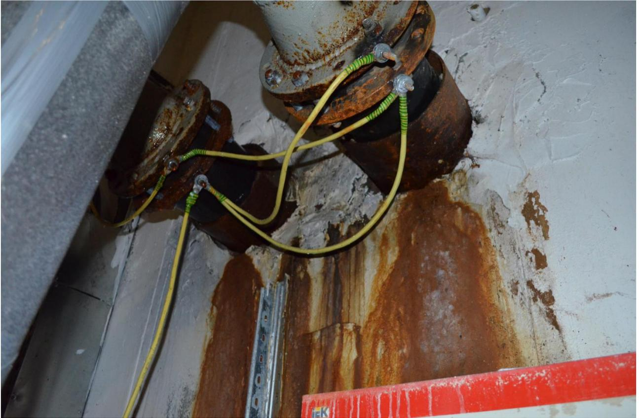
3.7 Отсутствует гидроизоляция пола, мокрые стены, мокрый пол.
