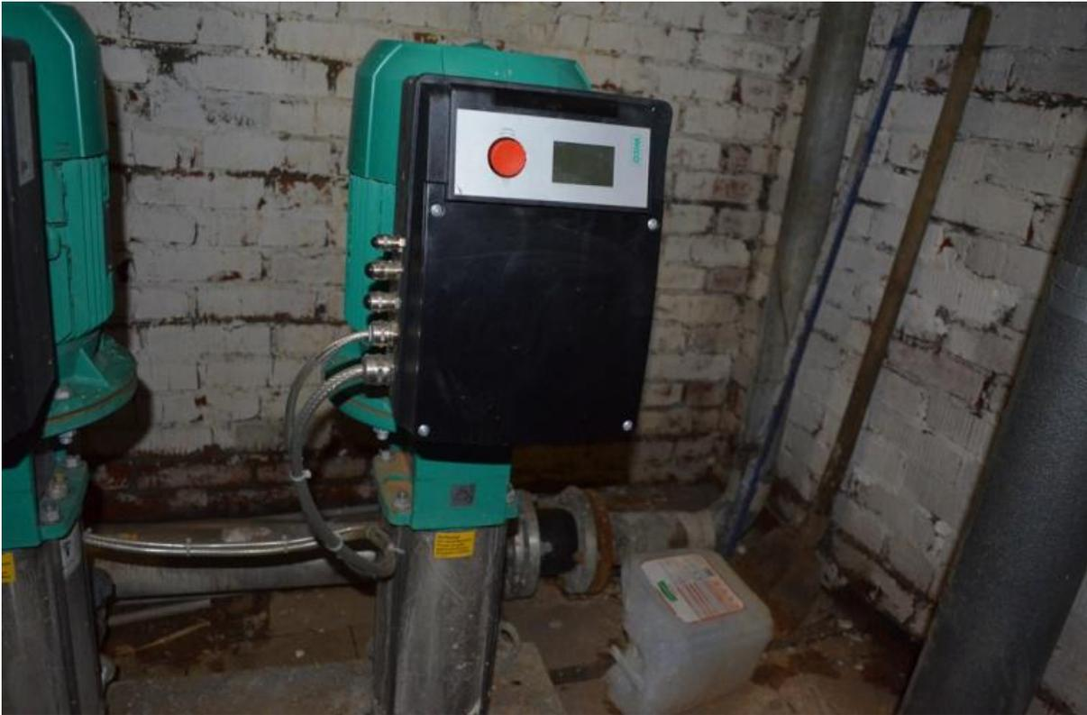
3.6 Отсутствует гидроизоляция примыкания трубопроводов подачи холодной воды и стены дома. Присутствуют течи. Частичное разрушение стены.
