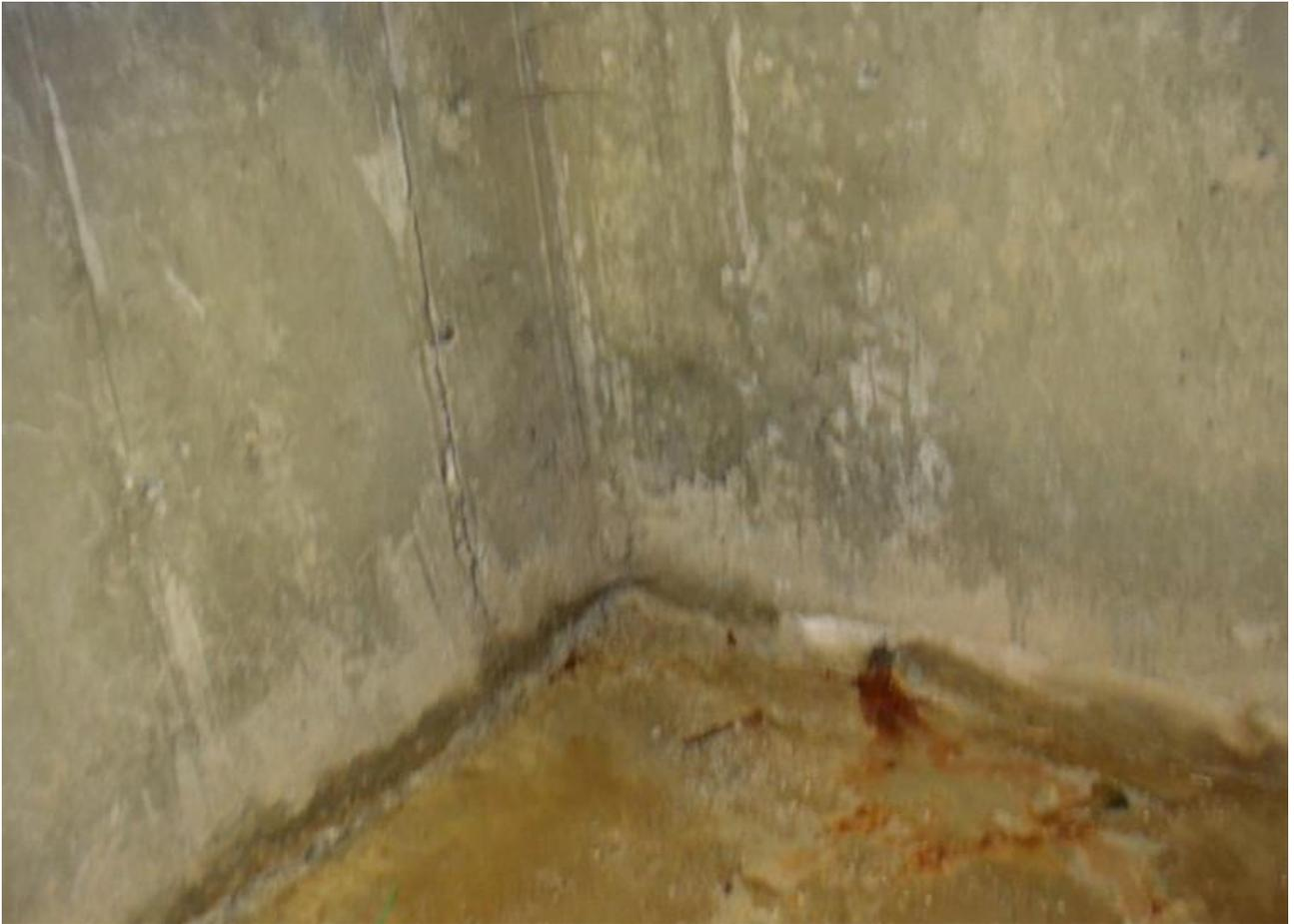
4.2 Отсутствует гидроизоляция стен фундамента. Фундамент подмывается сточными вода, что ведет к дальнейшему разрушению. Плесень. Грибок.
