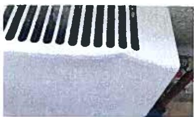
15. На стальных конвекторах отсутствует устройство для удаления воздуха из системы отопления квартиры
