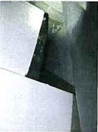
8. Не качественно выполнены РАБОТЫ ПО ПАРОИЗОЛЯЦИИ ГЕРМЕТИКОМ НА БАЛКОНЕ. СЛЕДЫ ПРОТЕЧЕК, РЖАВЫЕ АНКЕРНЫЕ ПЛАСТИНЫ, СКВОЗНЫЕ ОТВЕРСТИЯ НА УЛИЦУ.
